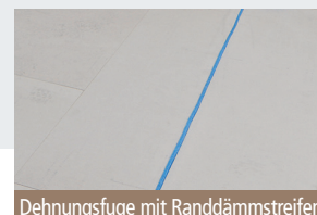
Dehnungsfuge mit Randdämmstreifen
